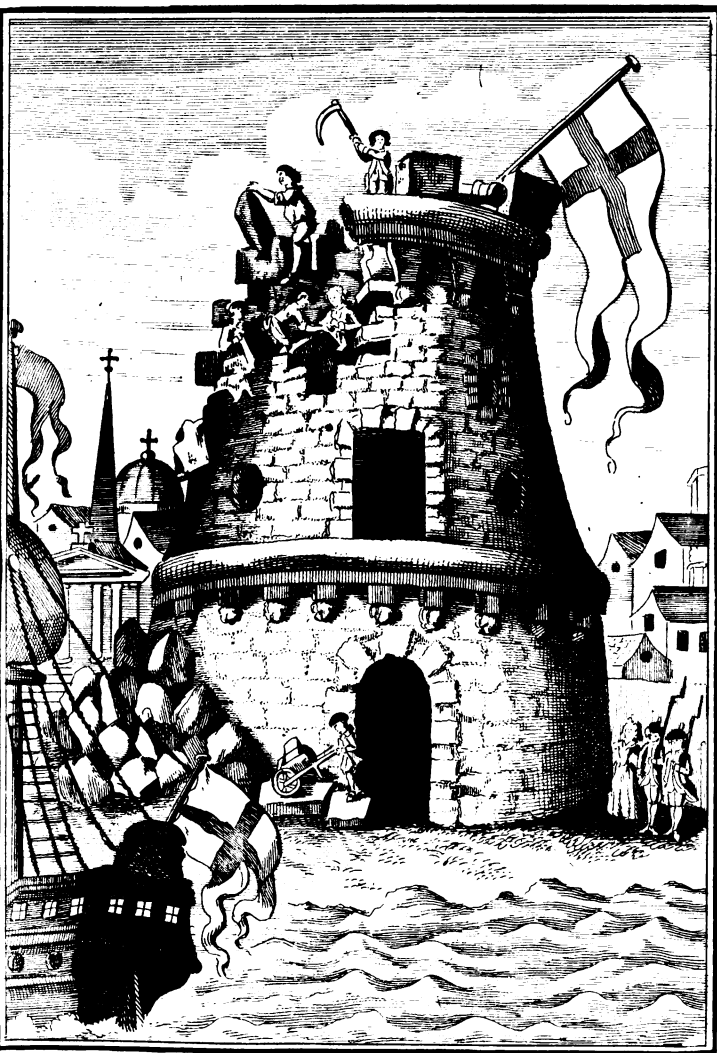
Démolition du Fort S. t Jean près Marseille
